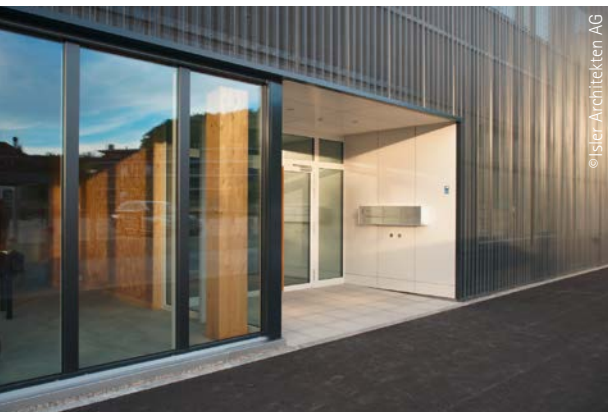
Eingang der Monolicht GmbH: Fenster mit folierten Profilen des Systems SOFTLINE 82 MD .
